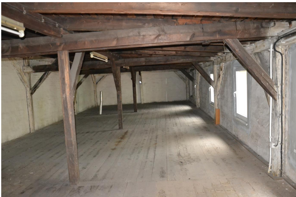
Fot. 7. Widok ogólny konstrukcji dachu budynku gospodarczego
