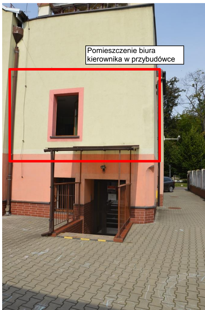
Fot. 1. Elewacja południowo-wschodnia przybudówki południowej [1.5].
