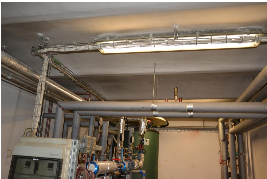
Fot. 5. Widok stropu odcinkowego [1.6].
