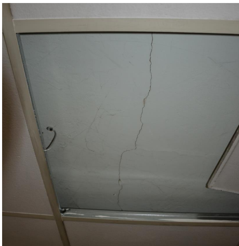
Fot. 6. Widok stropu drewnianego [1.6].
