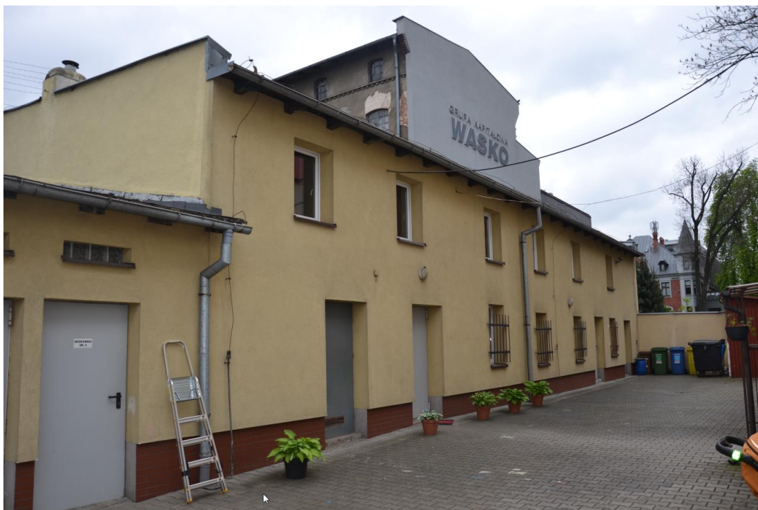
Fot. 3. Widok ogólny na budynek gospodarczy – część zachodnia [1.6].
