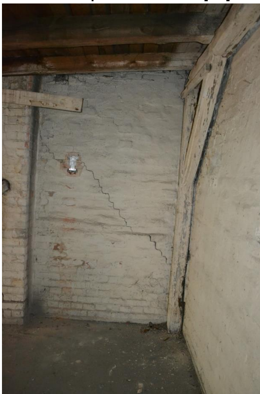
Fot. 21. Rysomierz zamontowany na ścianie przy filarku i kominie [1.6].
