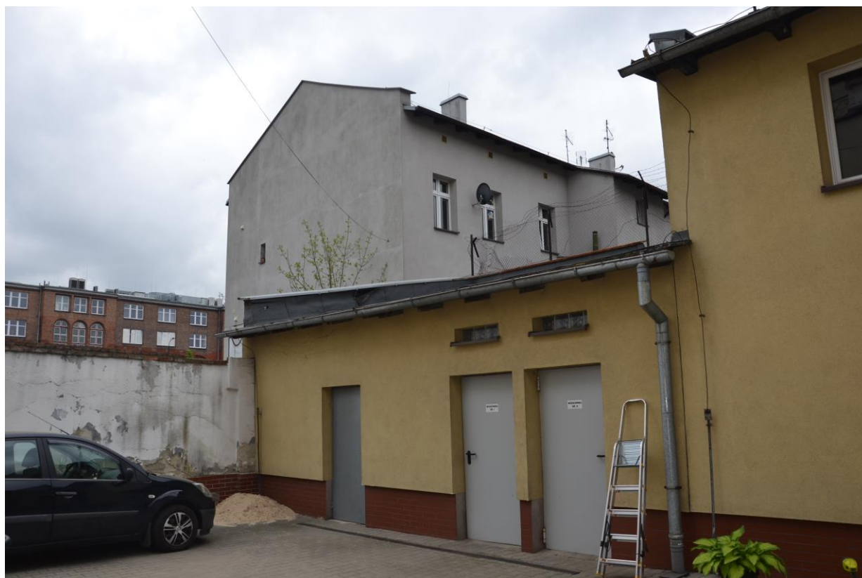
Fot. 2. Widok ogólny na budynek gospodarczy część wschodnia [1.6].
